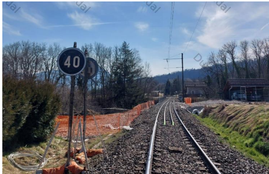
LTV 40 km/h après pose des rails de sécurité
